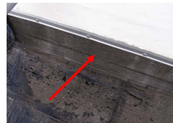
Korrekt udført inddækning/overgang til teknikhus.
