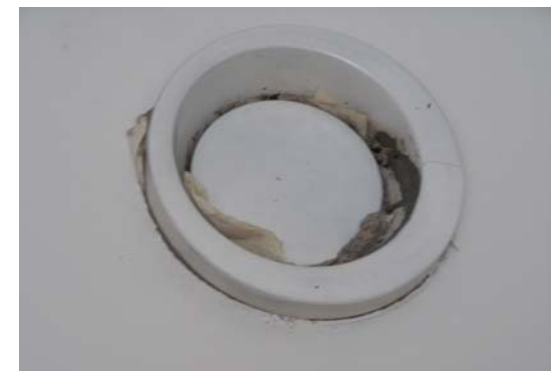
Tilstoppet ventilationsventil.
