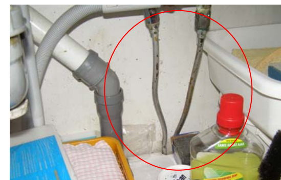
Galvaniserede koblingsledninger i køkken lejlighed 207.
