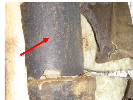
Støbejernsfaldstamme i lejlighed 305 viser ingen tegn på utæthed.
