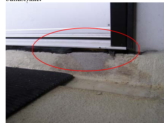
Oprindelig lejlighedsdør med delvis nedbrudt, løst bundstykke.
